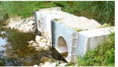
▲ Absperrbauwerk Zeller Kanal zum Entwässerungsgraben
