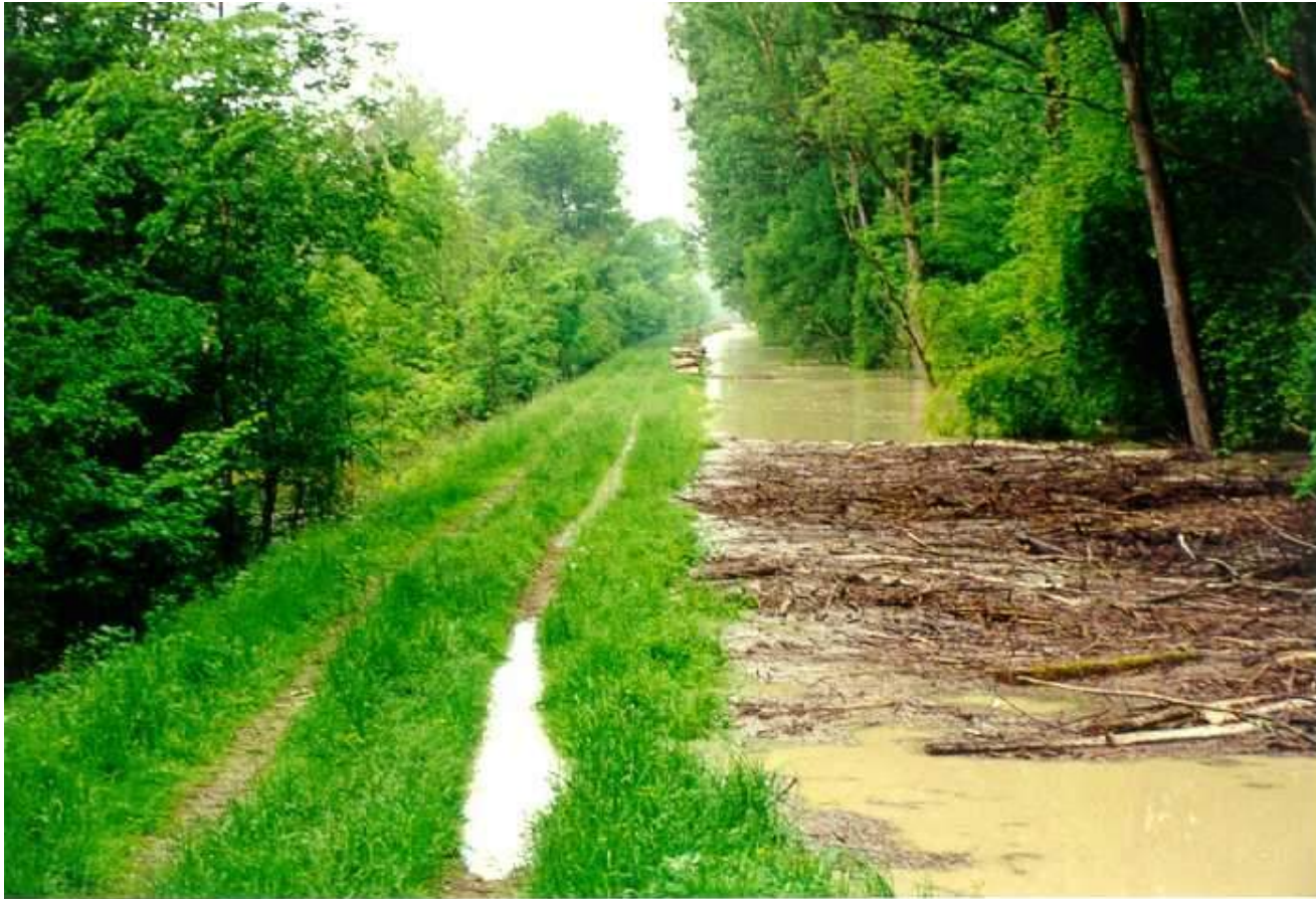
Mitteldeich zwischen Vohburg und Münchsmünster beim Pfingsthochwasser 1999 (ca. HQ200)
