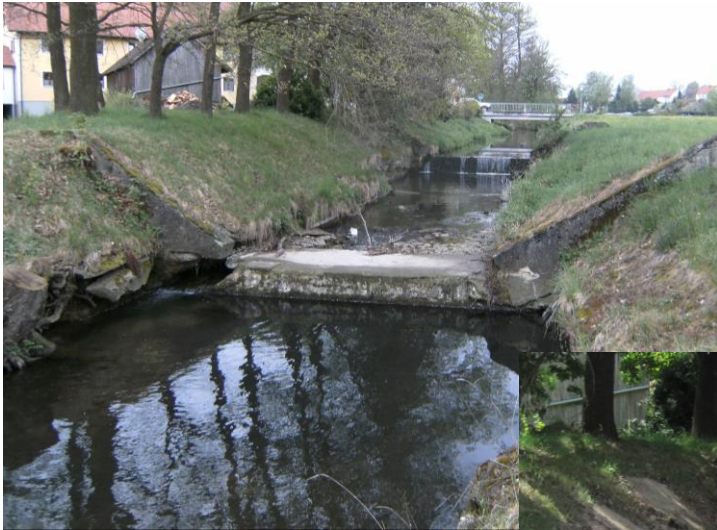
Umbau zweier Abstürze in eine flache Riegelrampe im Ortsbereich Aresing
