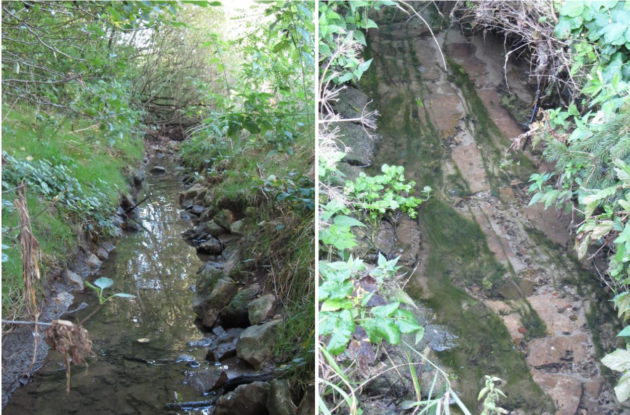
Ufer- und Sohlverbau am Oberlauf der Weilach
