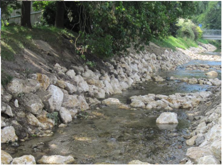
Umbau zweier Abstürze in eine flache Riegelrampe im Ortsbereich Aresing
